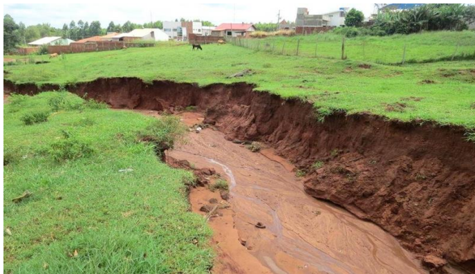
Área afetada pela erosão
