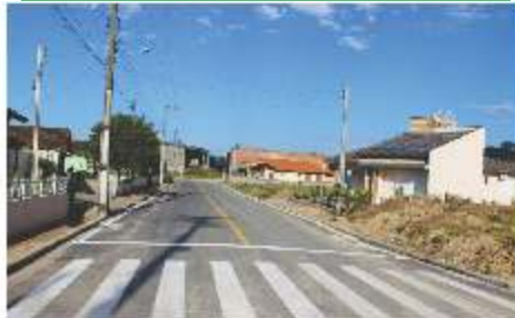
Pavimentação, Drenagem e Sinalização da Rua Álvaro de Oliveira Souza.
