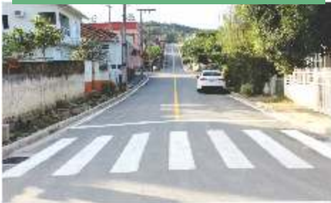
Pavimentação, Drenagem e Sinalização da Rua Pe. Vitorio Pozzo.
