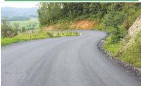
Pavimentação Asfáltica da Rodovia GPA 385, na Comunidade de Rio Cachoeirinhas.
