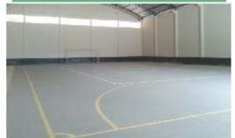
Ginásio de Aiurê (Reforma).
