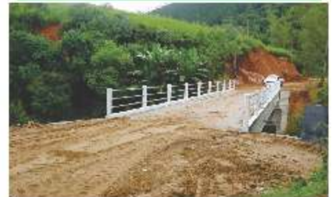
Construção da Ponte de Concreto Armado na Comunidade de Braço Esquerdo.
