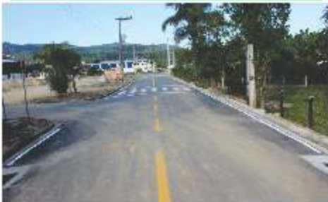
Pavimentação, Drenagem e Sinalização da Rua Altair de Oliveira Souza.
