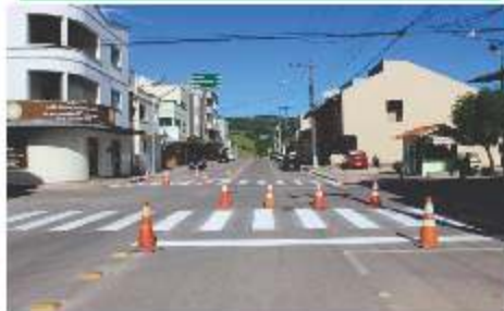
Pavimentação, Drenagem, Sinalização e Calçadas de Acessibilidade da Rua Nereu Ramos.
