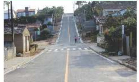
Pavimentação, Drenagem e Sinalização da Rua Francisco de Oliveira Souza.
