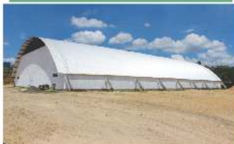
Ginásio de Linha Antunes Braga (Construção).
